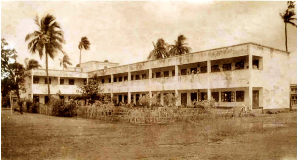
চিত্র-৬৫ : খুলনা রেডিও স্টেশনের পরিত্যক্ত ভবন, ১৯৮৩-১৯৯০ সাল পর্যন্ত এখানে খুলনা আর্ট কলেজের কার্যক্রম চলেছে, উৎস : শেখর মণ্ডল
