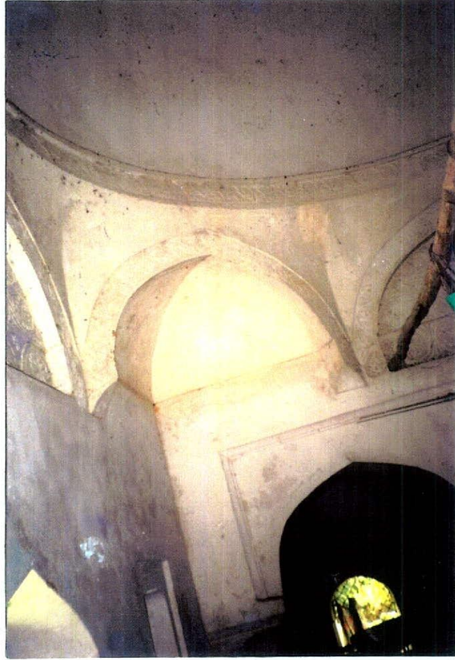
চিত্র - ২৮ : ওয়ালিপুর মসজিদ, গম্বুজ নির্মাণে ব্যবহৃত স্কুইঞ্চ
