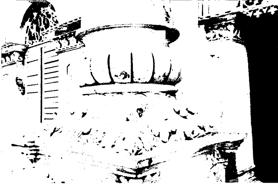
চিত্র -৭০ : স্তম্ভ ভিত্তিতে অমলক এর ব্যবহার, রোজ গার্ডেন, ঢাকা।
